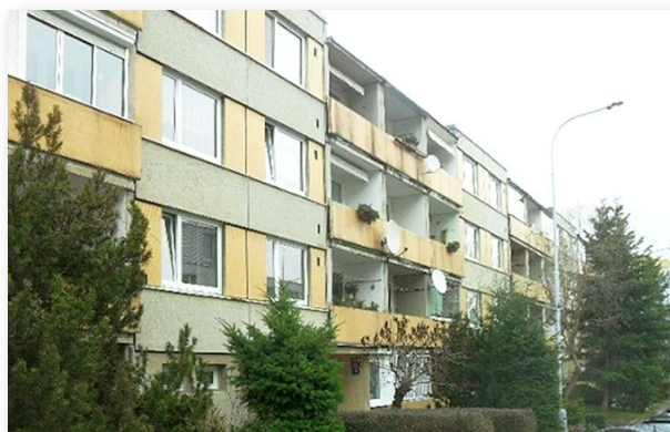
Komplex bytových domů v pražském Motole
